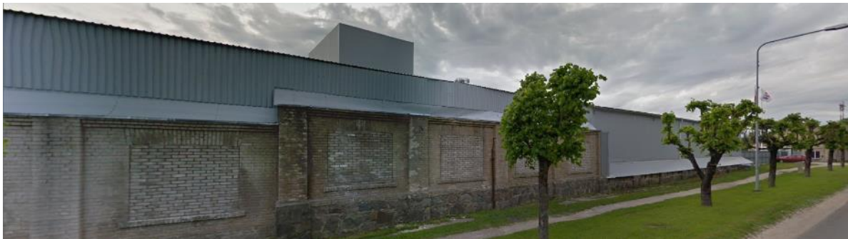
Tehaste tn 7 vundament
