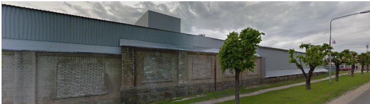
Tehaste tn 7 vundament
