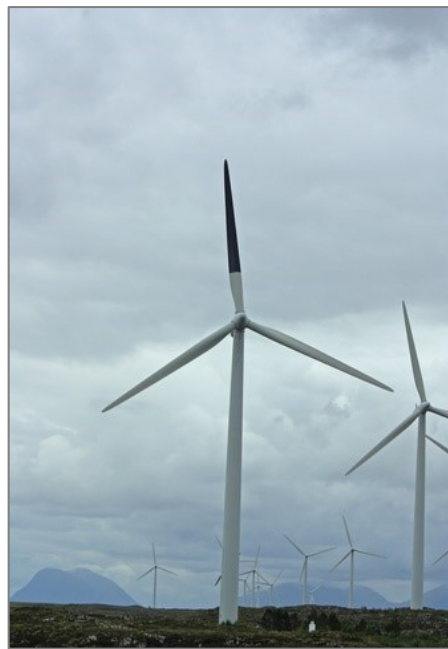
Joonis 6-24 Tuuliku labade visuaalse kontrasti suurendamise näide
