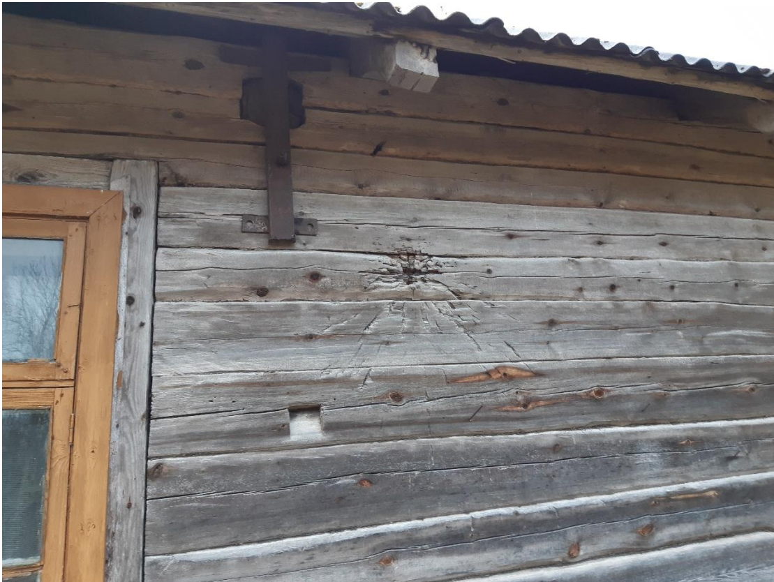
Joonis 3. Tänni säilinud sõjakahjustused Kiisa-Risti taluhäärberi välisseinal.
