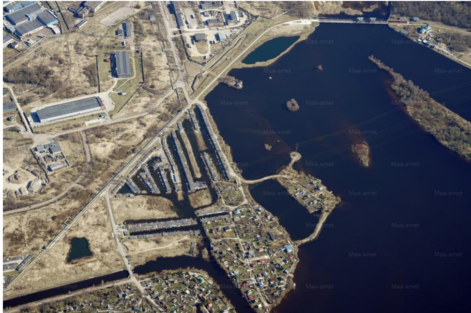
Foto 22. Vaade Kulgu paadigaraažidele, mis on ühendatud nii Narva veehoidla kui ka Kulgu kanaliga (Maa-ameti kaldaerofoto).
