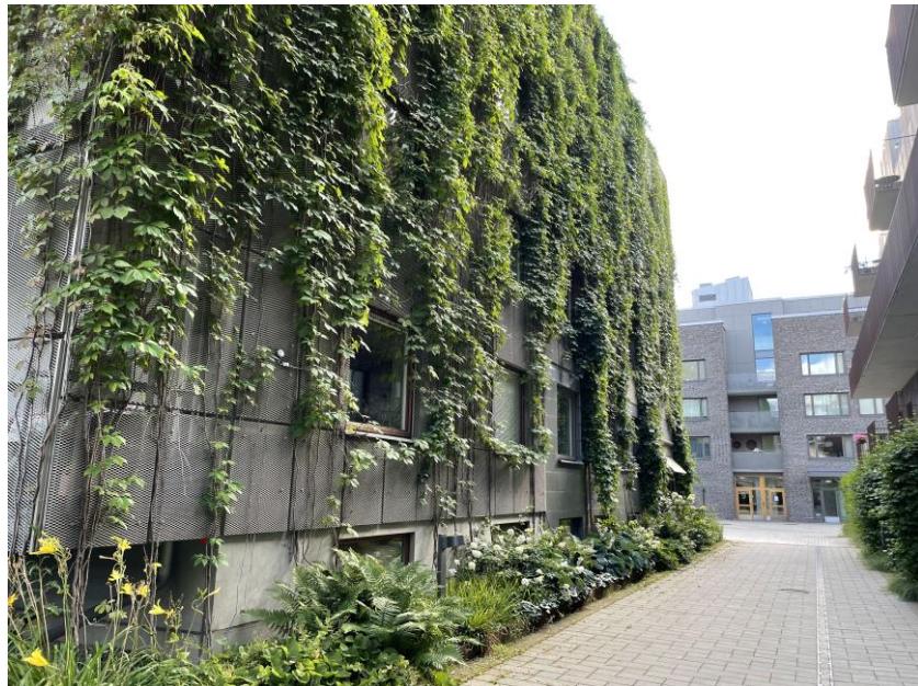
Fotod 75. Ronitaimedega haljastatud fassaadid, mis jahutavad kuumalainete ajal korterelamute siseruume .
