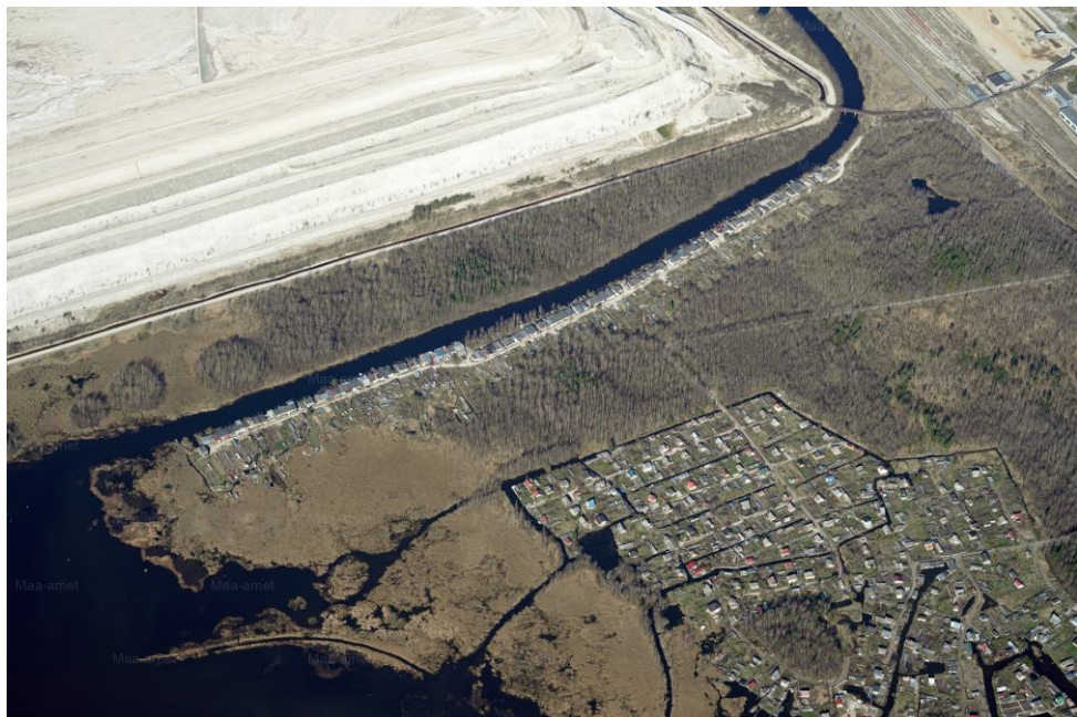
Foto 23. Vaade Kulgu kanaliäärsetele suvilatele (Maa-ameti kaldaerofoto).
